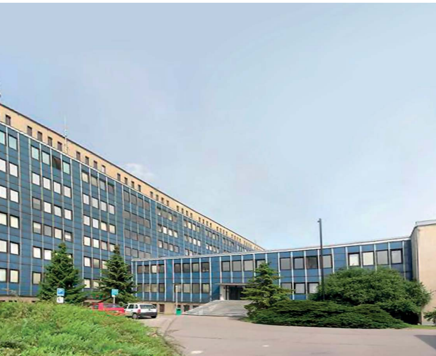
Nová budova Státního ústavu pro kontrolu léčiv před opláštěním (Zdroj SÚKL)
