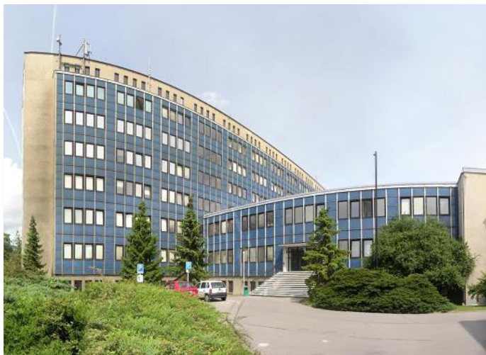
▼ Nová budova Ústavu před opláštěním (SÚKL)
